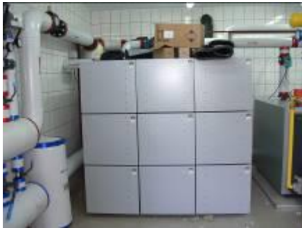
Zasobnik wielkoformatowy FMS wykorzystywany w budynkach użyteczności publicznej. fot. Wolf
