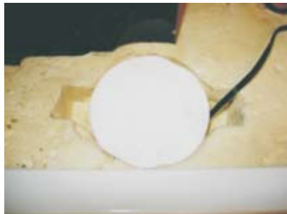
Tapar las conexiones con la tapa aislante
