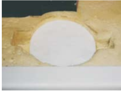
Quitar la tapa aislante situada encima del ánodo sacrificial
