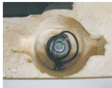
Wybudować istniejącą anodę
