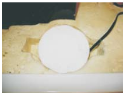
Aansluitingen afsluiten met isolatie dekseel.
