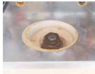
Wybudować istniejącą anodę
