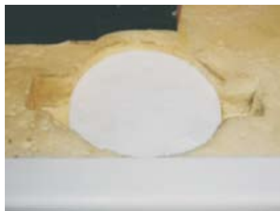
Zdjąć pokrywę z istniejącej anody
