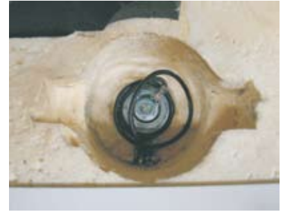
Desmontar el ánodo sacrificial
