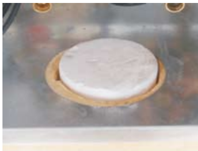
Zdjąć pokrywę z istniejącej anody
