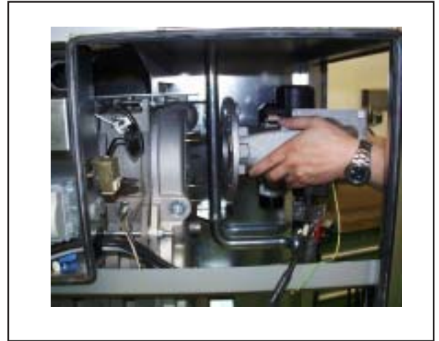
Bild: Einheit aus Brennerflansch und Gebläse abnehmen
