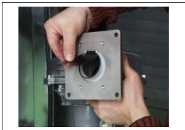
Bild: Sichtkontrolle Rückstromverhinderer
