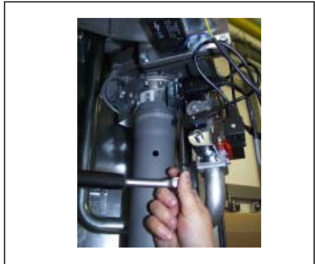
Bild: Schrauben zwischen Gebläse und Mischkammer lösen
