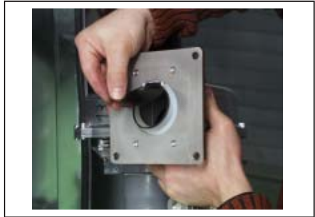
Bild: Sichtkontrolle Rückstromverhinderer
