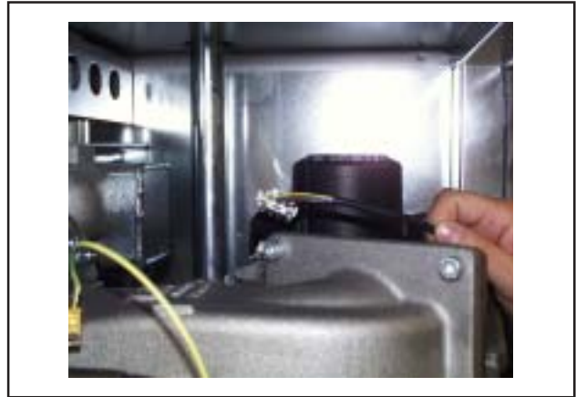
Bild: Alle elektrischen Anschlüsse lösen am Gebläse und Zündtrafo
