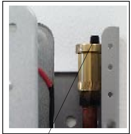
Rys.: Śruba odpowietrzająca na odpowietrzniku
