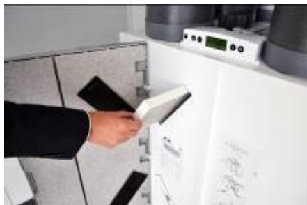
Wymienny filtr zastosowany w Rekuperatorze CWL-400 Excellent
